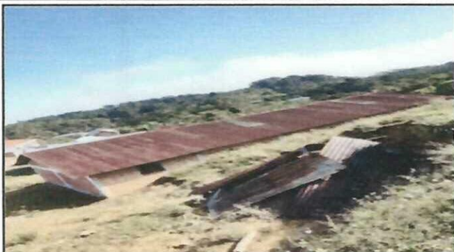
Foto 1: Se puede observar la parte de atrás del Centro Educativo y se verifica el oxido y el deterioro de las láminas.
